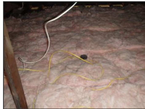
loose circuits--example
