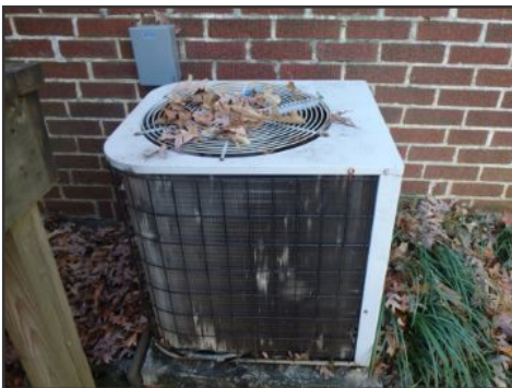
ICP brand condenser--2.5 tons--25 years old
